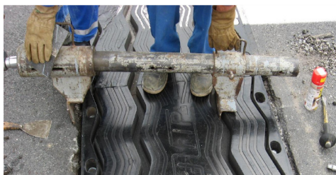
Slika 2.5.6.4: Podešavanje tepih dilatacije sa pomičnim mehanizmom za izvlačenje/kompresiju
